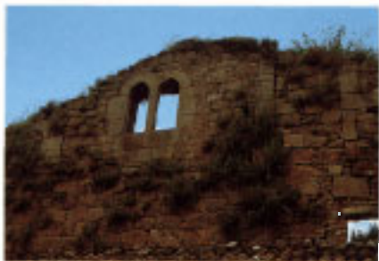
Ruinas del Palacio de Alzolaras.
