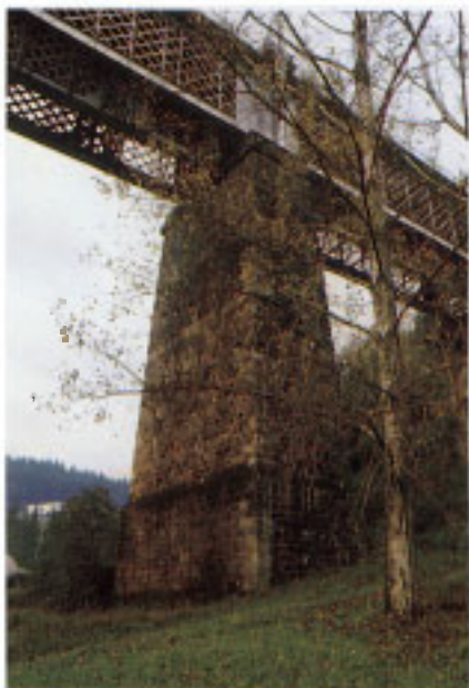
Viaducto de Ormaiztegi.
