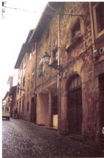
Casa nº6 de la calle San Roque.
